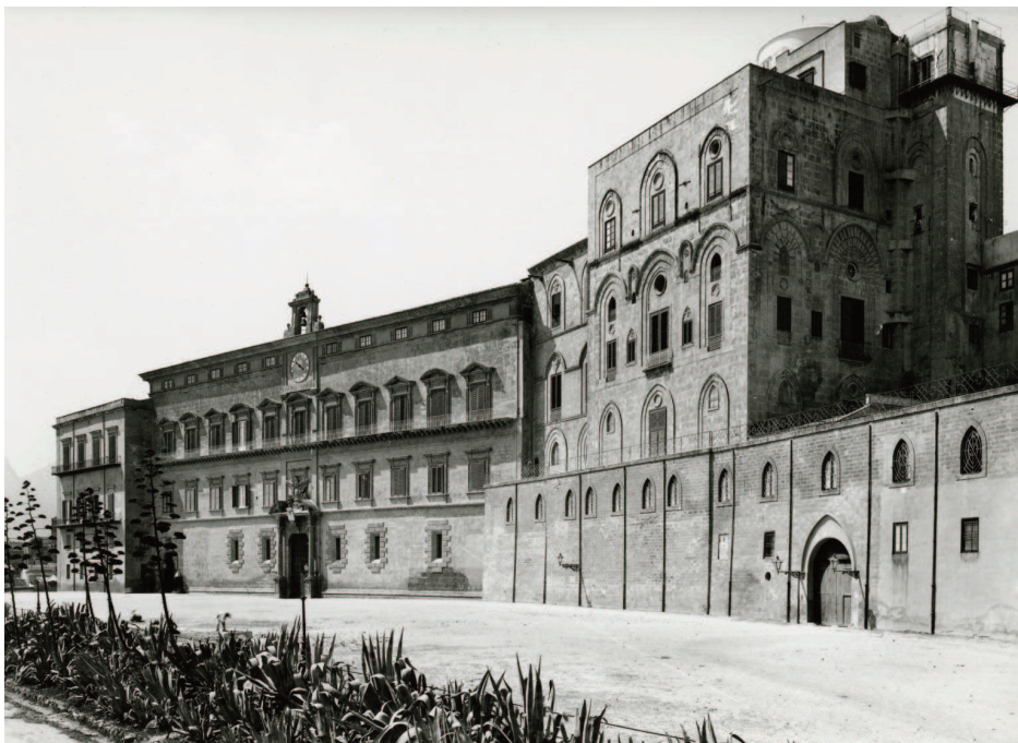
Fig. 1: Piazza del Parlamento. Facciata del Palazzo dei Normanni agli inizi del secolo scorso. In facciata è ancora presente l'orologio voluto dall'astronomo Piazzi sovrastato dal piccolo campanile, rimossi nel dopoguerra.
