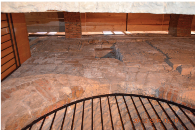
Fig. I, 18: Tela muraria sopra il fornice d'ingresso alle Segrete.
